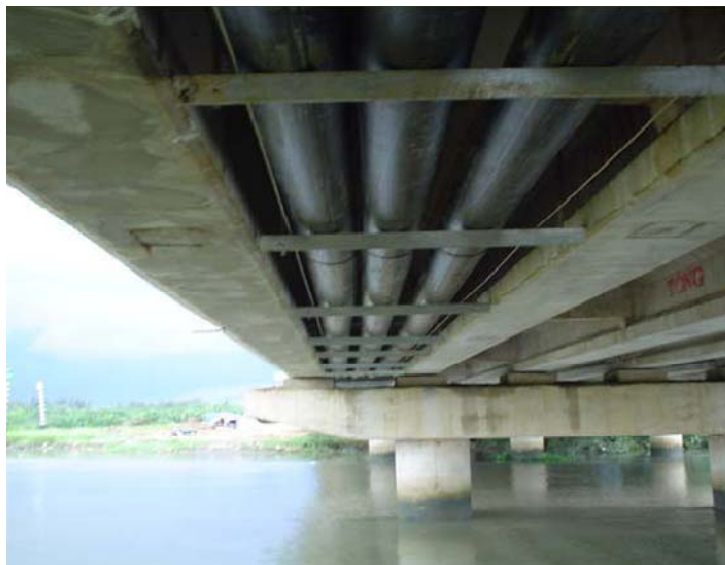
Mynd 16 Strengur lagður undir brúargólf
