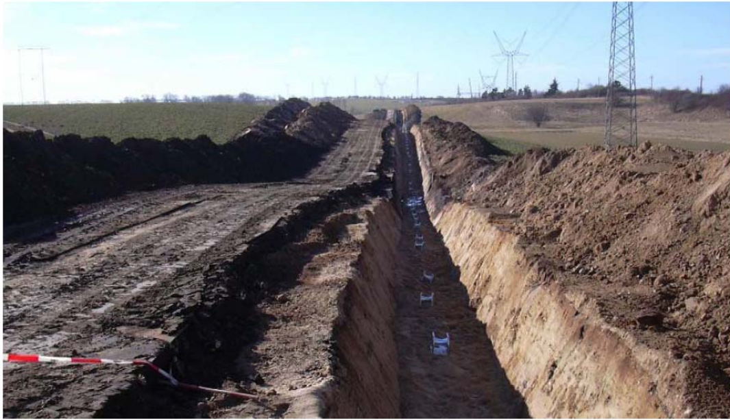
Mynd 32 Strenglögn í opnu landi - Skurður og einfaldur slóði
