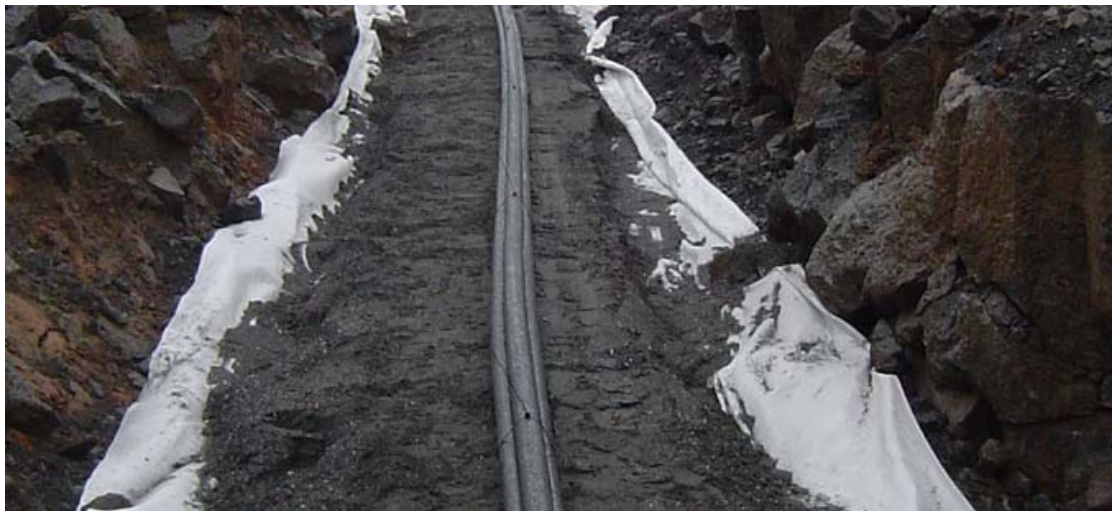
Mynd 21 Jarðstrengur lagður í þríhyrning, 132 kV, 500 mm 2 álleidari.
