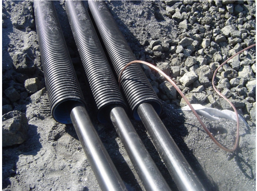
Mynd 17 Strengir lagðir í rör í vegþverun
